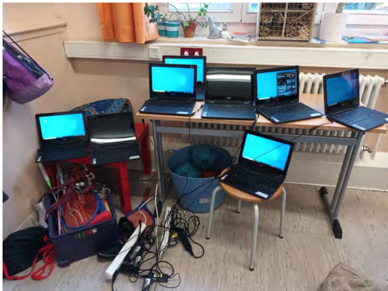
Eine selbstgebastelte Ladestation in einer Wuppertaler Grundschule.
